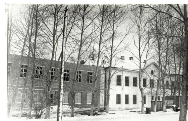
Возведение пристроя к школе
